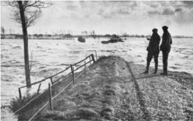
Den doorgebroken Maasdijk
